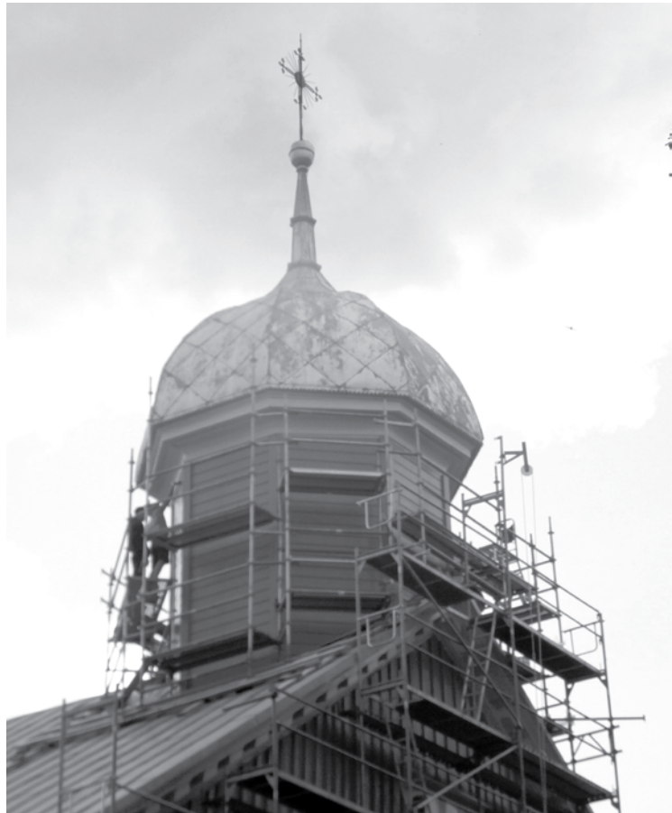
Pastoliais „apsiūtas“ Svėdasų bažnyčios bokštas.
